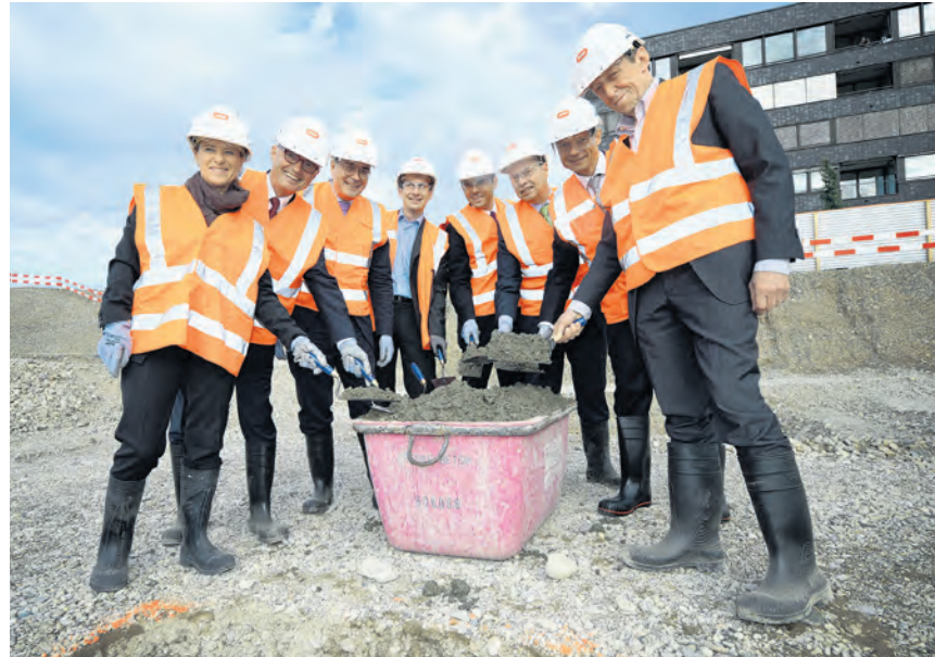
Grundstein gelegt. Christoph Brutschin (3.v.l.) und Kantonsbaumeister Fritz Schumacher (r.) mit Vertretern der Bauherrschaften und -firmen. Foto Dominik Plüss
